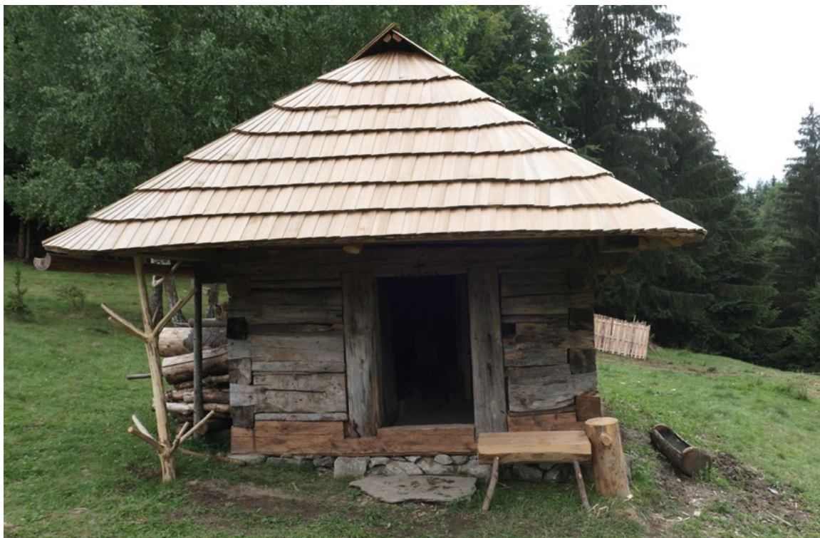
Obr. 15 Koliba, ktorej časti sú dendrochronologicky datované až do 17. storočia, pôvodne z Javorinky, presťahovaná na laznícku osadu Štoliansko, zachovaných 60 % pôvodných prvkov, OZ Krnofeľ. Foto: V. Kotradýová, 2020.
