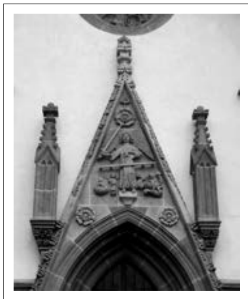
11 Vstupný portál Kaplnky sv. Michala
