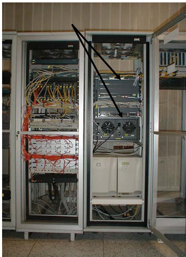
Obr.1 Dovybavený kostrový prepínač v sále VS SAV
