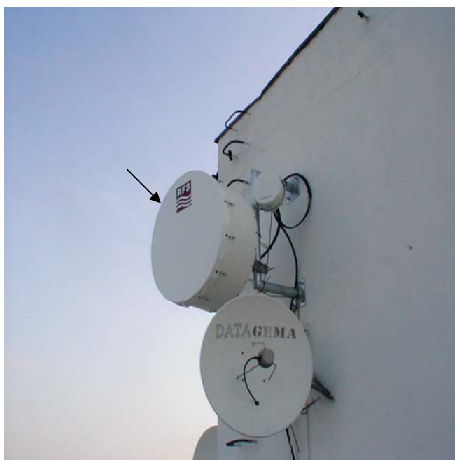
Obr.3 Parabola RR spoja - na budove internátu MTF STU Trnava
