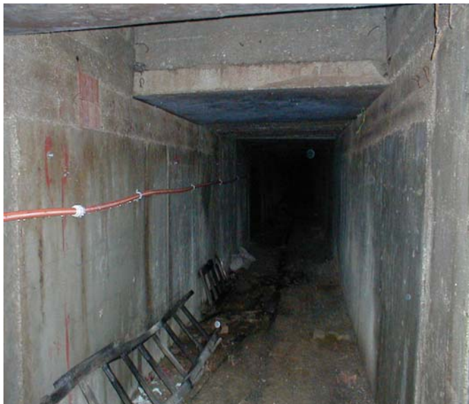
Obr.4 Priebeh optického kábla v HDPE chráničke v odbočnej vetve kolektoru do ŠÚV
