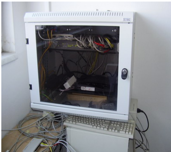
Obr.5 Nástenný rozvážač v počítačovej učebni ŠÚV
