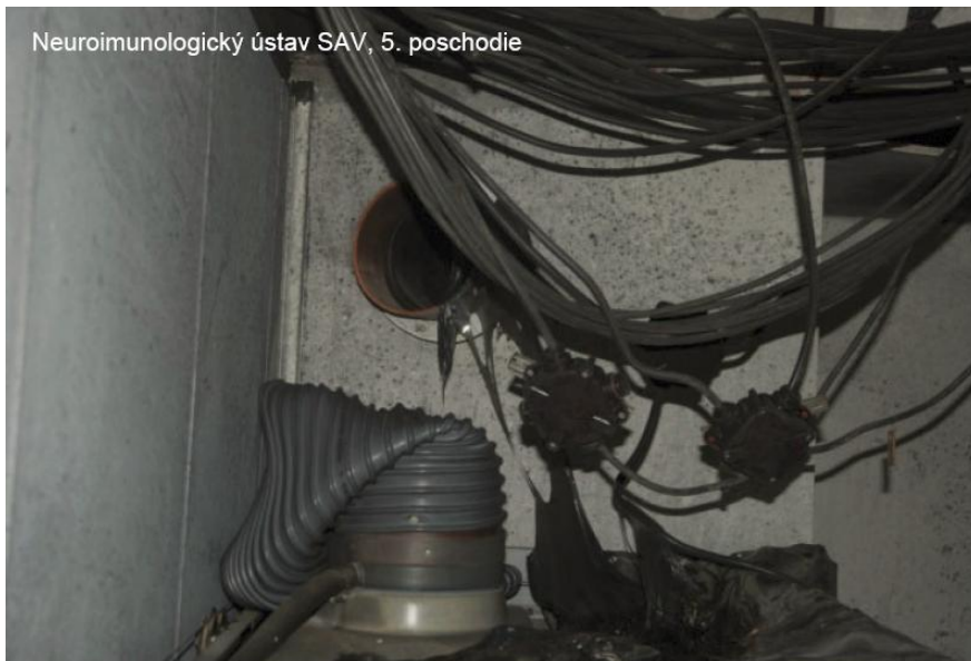
Zhorený digestor a elektroinštalácia s počítačovými sieťami po požiari
