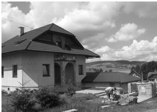
Obr. 7. Výstavba rodinného domu svojpomocou
