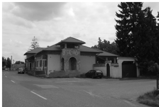
Obr. 4. Postupná rekonštrukcia a dostavba polyfunkčného objektu
