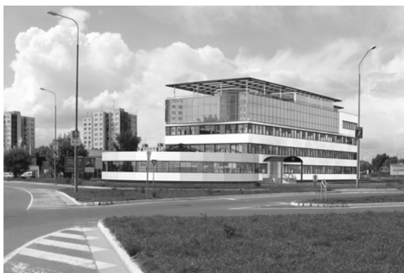
Obr. 21. Polyfunkčný objekt MEDIREX, Bratislava (Stec 2006b)
