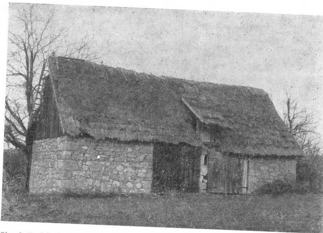
Obr. 8. Stodola (*pajta*) v Brhlovciach; ako stavebný materiál použitý odpad z kamenárskej výroby.
