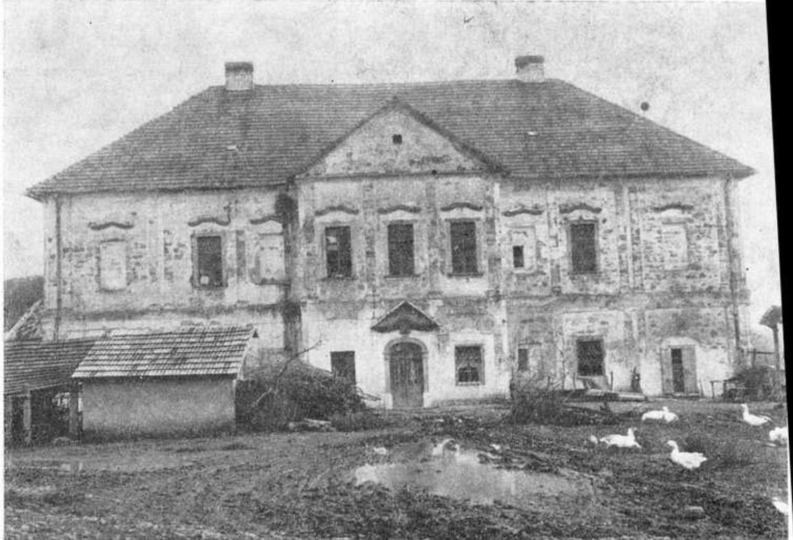
Obr. 6. Kaštieľ v Brhlovciach, postavený v 70. rokoch 18. stor.; portál a obločné zárubne z miestneho trachytového tufu.
