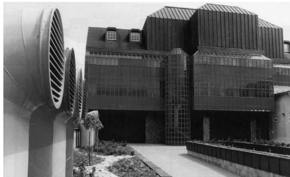
Zadný pohľad na Štúdio Slovenského komorného divadla Martin. Charakterizuje budovu ako fabriku na umenie. Pod strechou vidno zasklené ochodze. Architektonický návrh Ing. arch. Mikuláš Rohrböck a Ing. arch. Vladimír Kordík. Snímka archív Divadelného ústavu.
