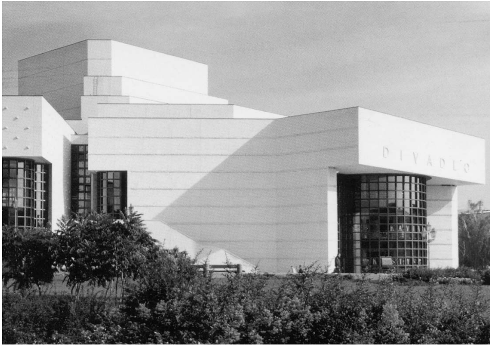
Bočný pohľad na novostavbu Divadla Andreja Bagara v Nitre. Napravo hlavný vchod do budovy. Architektonický návrh Ing. Juraj Hlavica. Snímka archív Divadelného ústavu.
