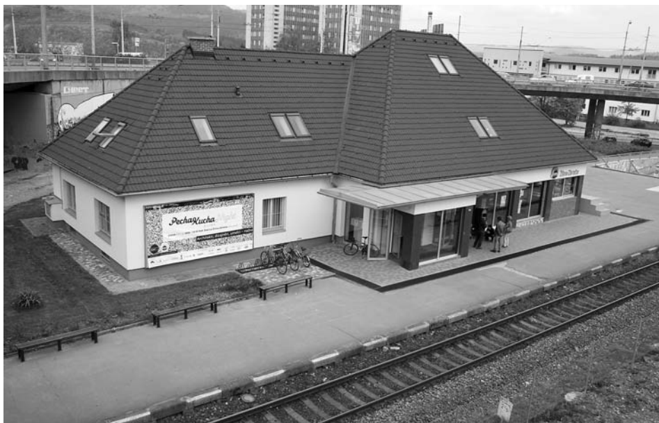
Pohľad na budovu Stanica Žilina-Záriečie. Autor fotografie Dušan Dobiáš. Archív Stanice Žilina-Záriečie – kultúrny uzol.
