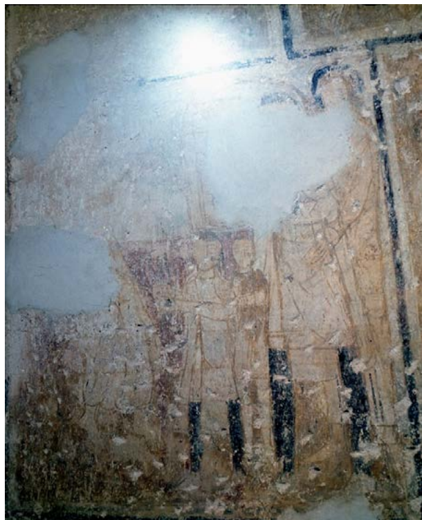
Obr. 1: Donátorská scéna na južnej stene lode. Foto: Archív PÚ SR.
