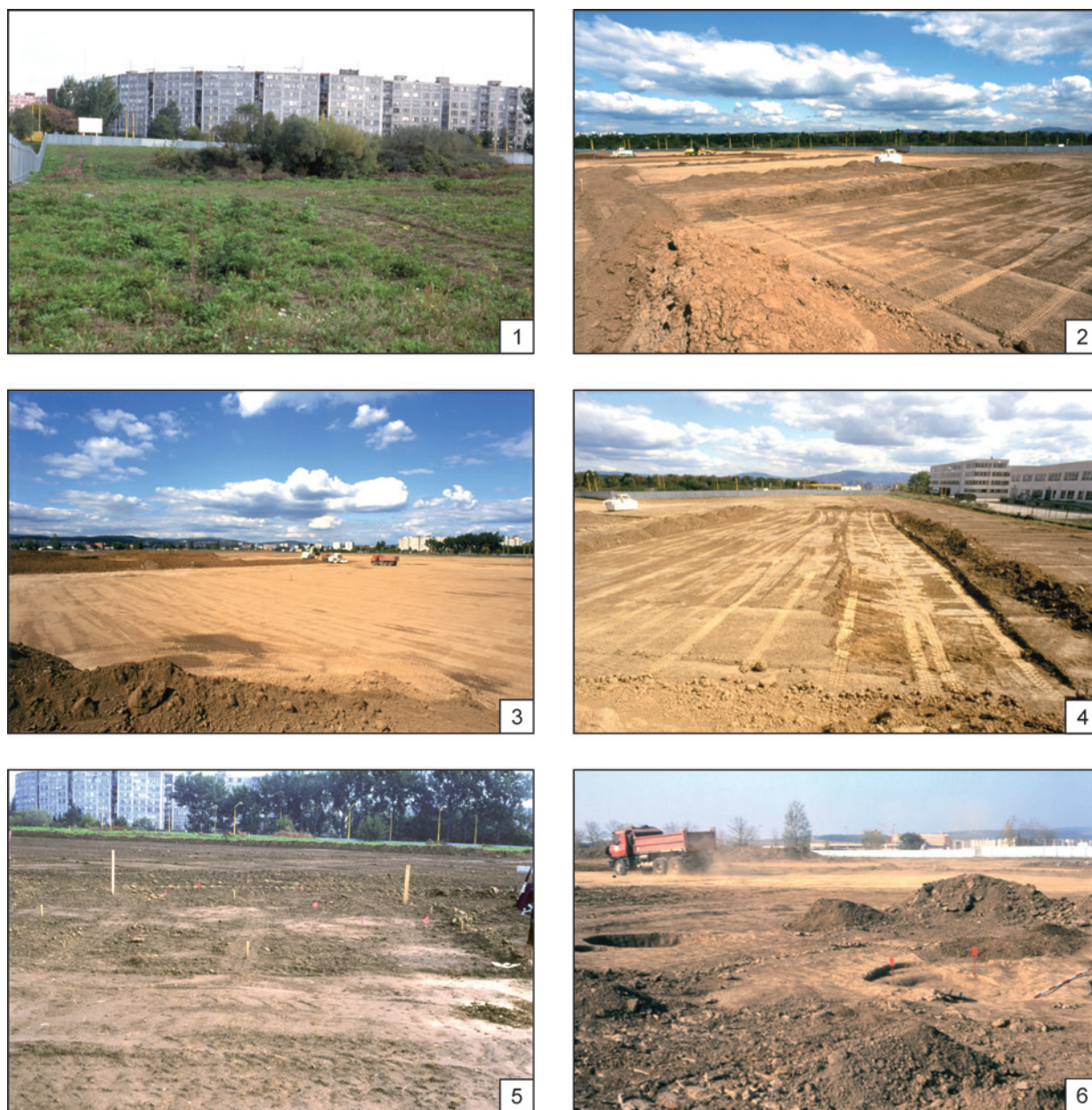
Obr. 4. Košice-Táborisko. Plocha stavby OC Cassovia.
