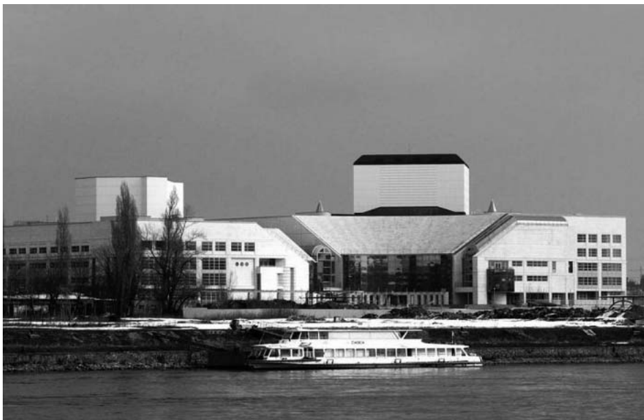
Situovanie novostavby na Dunajskom nábřeží sa ukázalo ako veľmi prezieravé. Snímka archív Správy kultúrnych zariadení.
