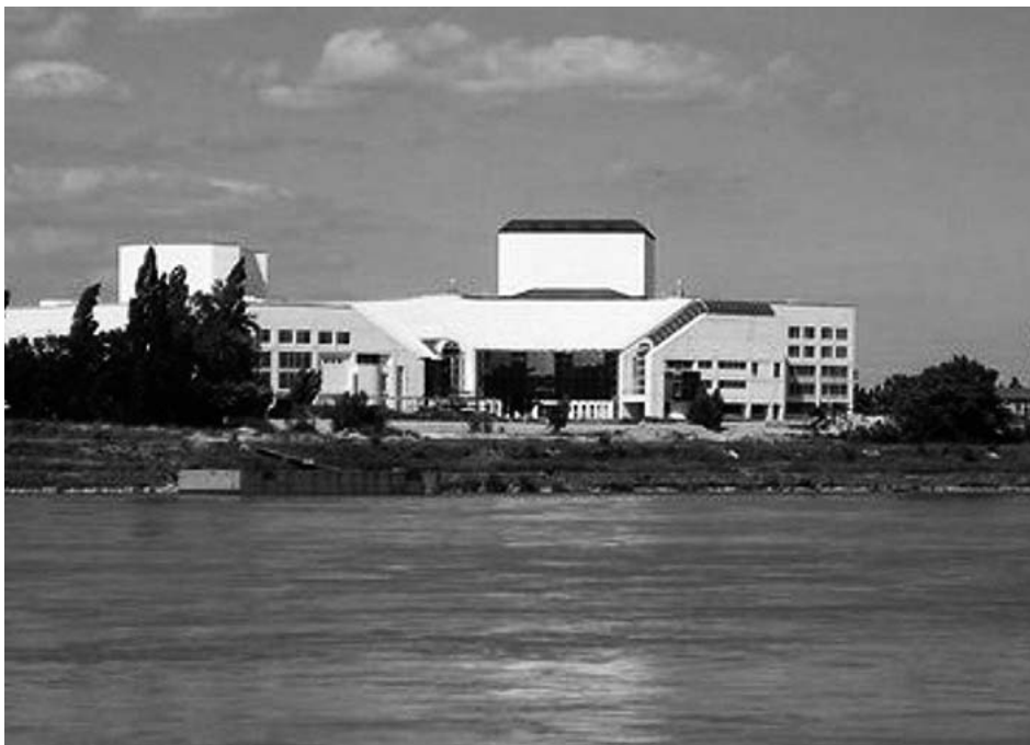
V bezprostrednom okolí nového Národného divadla vyrastajú v súčasnosti objekty nového spoločensko-obchodného centra slovenskej metropoly. Snímka archív Správy kultúrnych zariadení.
