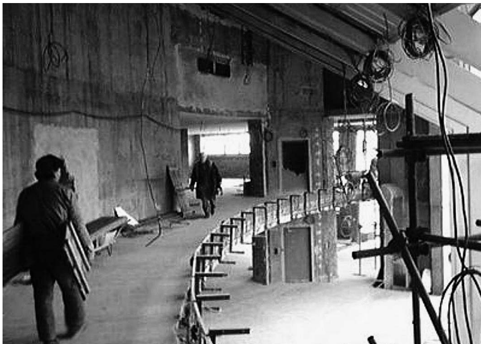
Hrubá stavba budovy Národného divadla. Snímka archív Správy kultúrnych zariadení.
