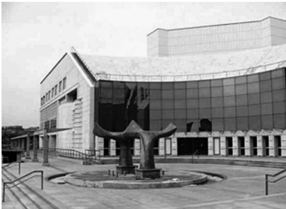
Pohľad na ukončené priečelie a fontánu ešte neznamenal, že práce na stavbe finišujú. Snímka archív Správy kultúrnych zariadení.
