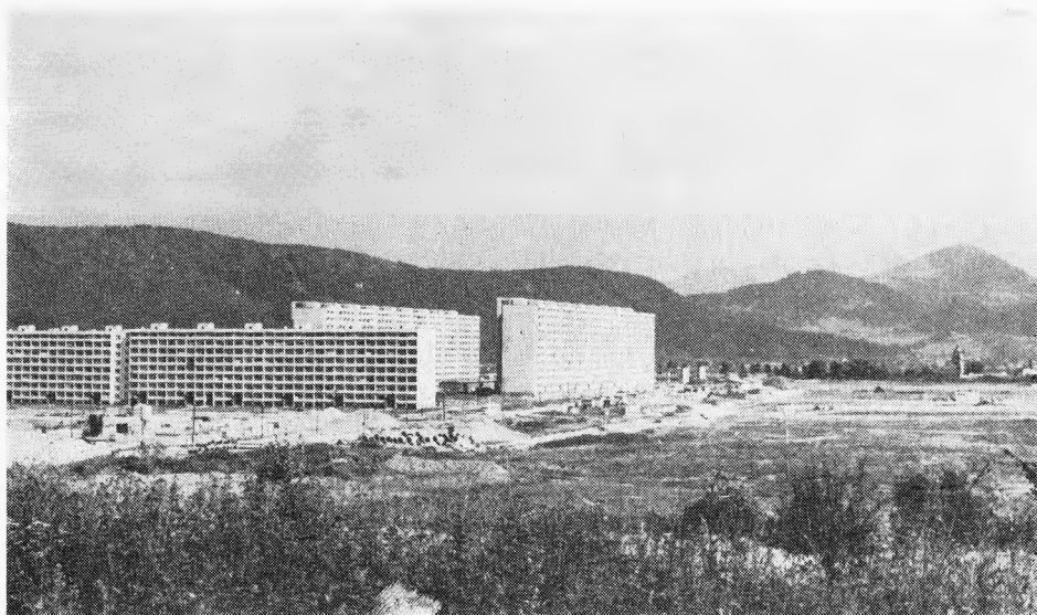
Obr. 1. Typ nevyužitej plochy vzniknutý procesom výstavby mesta (neupravené a nevyužívané okolie obytného útvaru).
