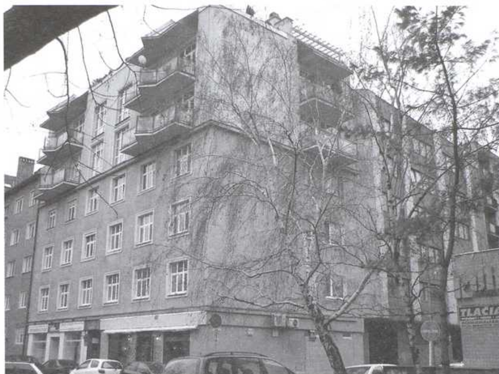
Obr. 6 Pôvodný dom Ráčkovcov z roku 1932. Reštituovaný deťmi Ráčkovcov v 90. rokoch 20. storočia. Rekonštruovaný, stav v roku 2010. Bratislava
