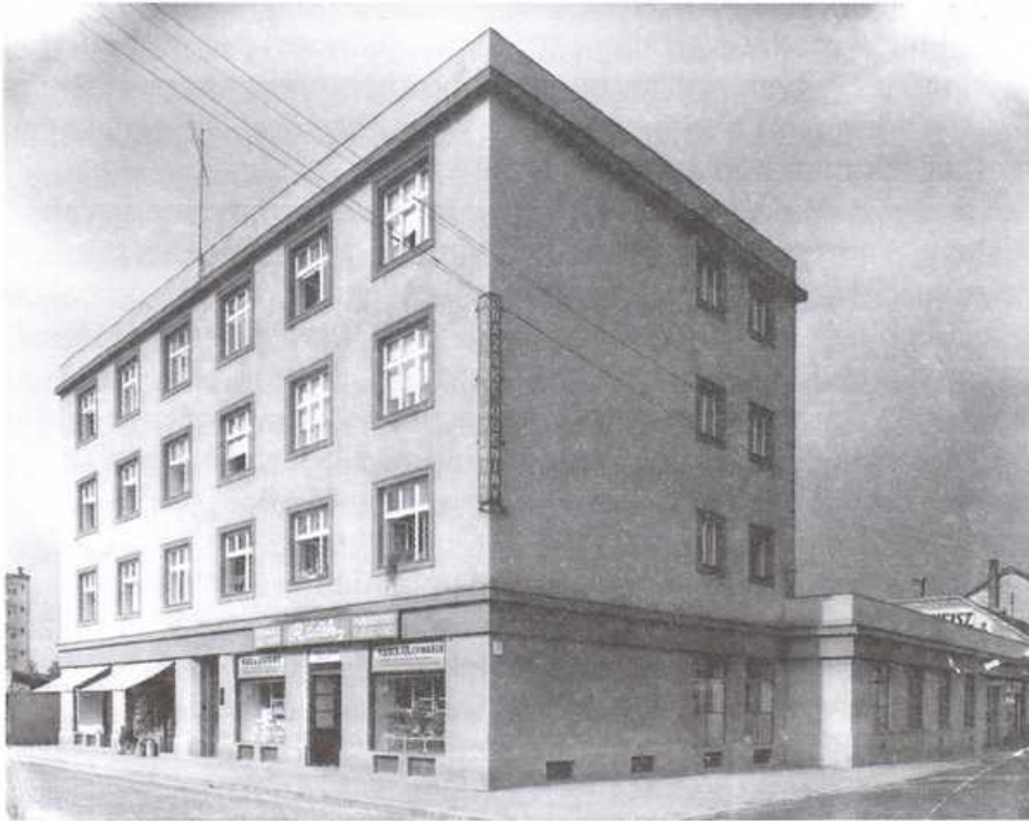
Obr. 2 Dom B. Ráčka postavený v r. 1932 s obytnou časťou a obchodmi na Vajnorskej ulici, prízemná budova s dielňami. Bratislava 1933
