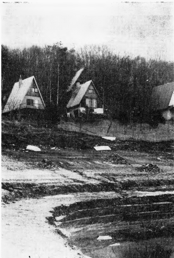
Obr. 4. Brehová abrázia v delúviách s typickými teraskami. V pozadí plytké zosuny vyvolané abráziou, ohrozujúce chatovú zástavbu.
