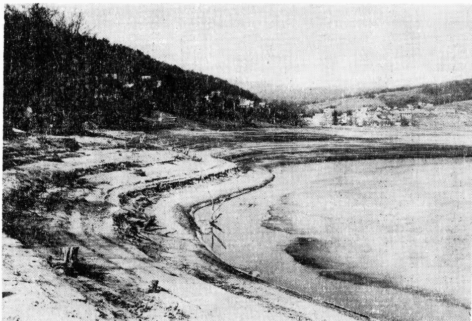
Obr. 1. Brehová abrázia na pravej strane Domaše južne od Valkova. Abrázne terasy vytvorené etapovitým poklesom hladiny. Vpravo suché dno nádrže a nové koryto Ondavy.
