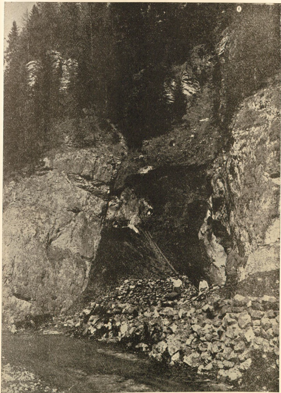
Obr. 1a. Prekopávanie nového vchodu na dno priepasti v Pustej r. 1950. Foto V. Benický.
