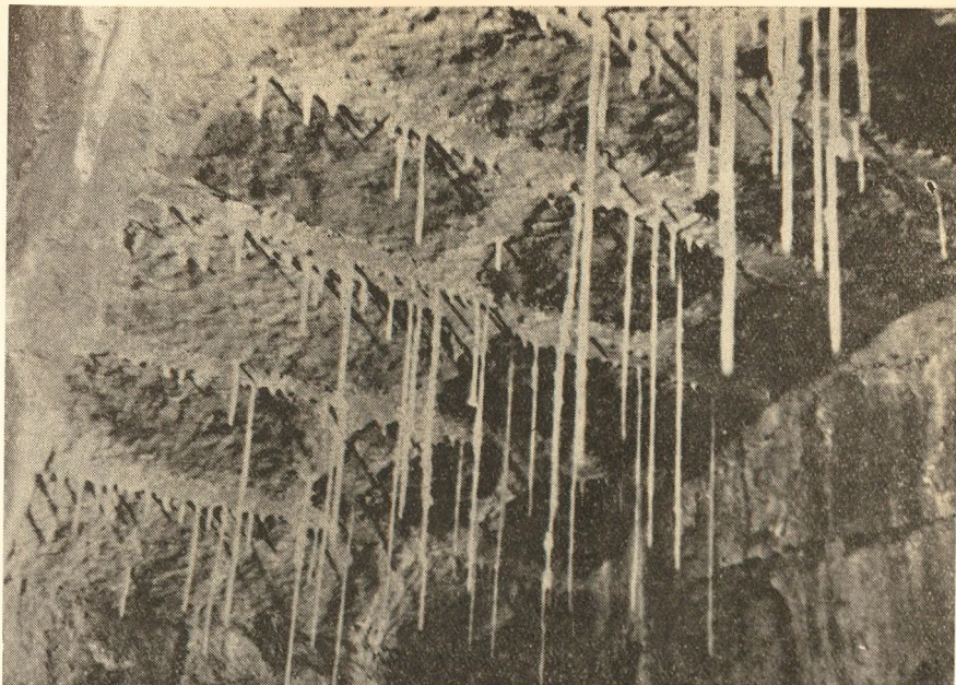
Obr. 6. Brčka vo výklenku tunela. Foto Ježka.
