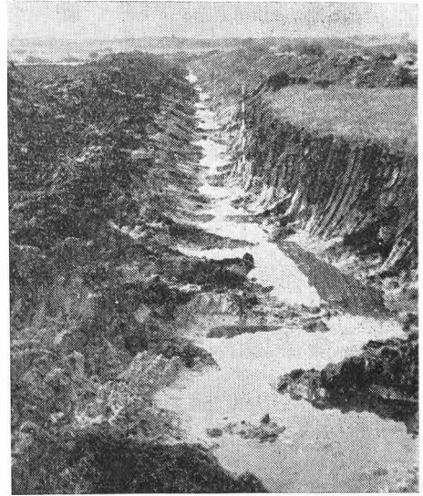
Obr. 5. Odvodnenie pomerne malej plochy rašelinísk medzi Zohorom a Stupavou spôsobuje nepriaznivý pokles hladiny podzemných vôd na veľkých plochách piesčitých poľnohospodárskych pôd narezaných kanálom.
