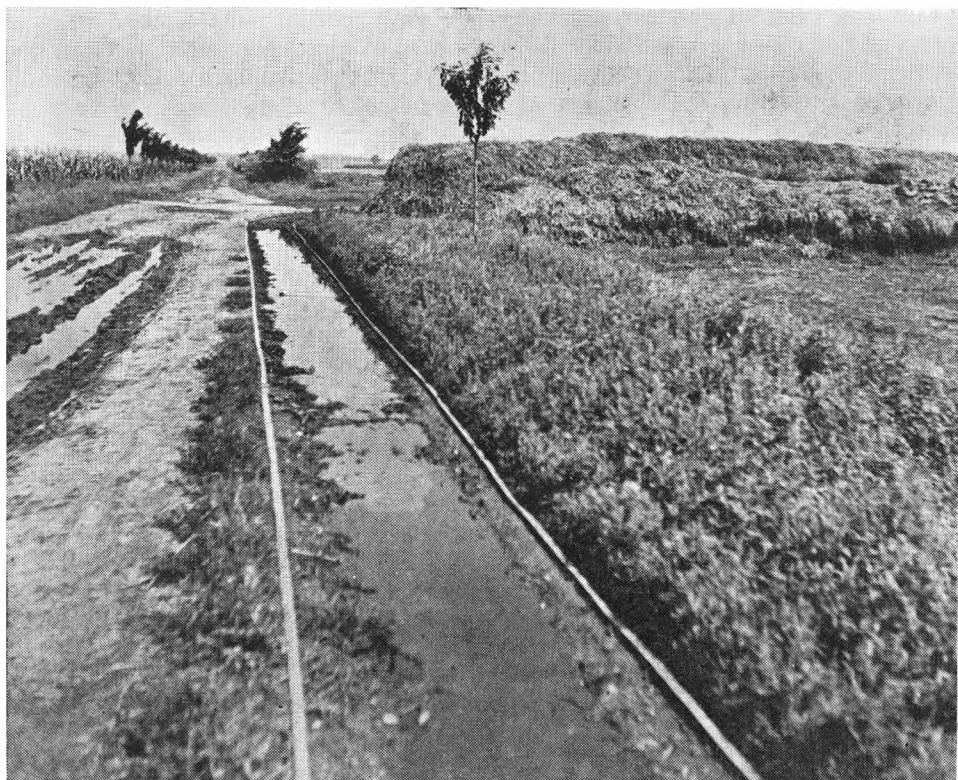
Obr. 1. Veľký význam má úzkokolejná železnica v jesennom období pri zbere cukrovej repy, keď poľné cesty (na sprášiacich, lebo tam sa najviac pestuje) sú rozmoknuté a takmer neschodné. Podobnú úlohu má pri vyvážaní umelého a maštalného hnoja na jar a na jeseň. Fotografia: J. T a r á b k o v á.
