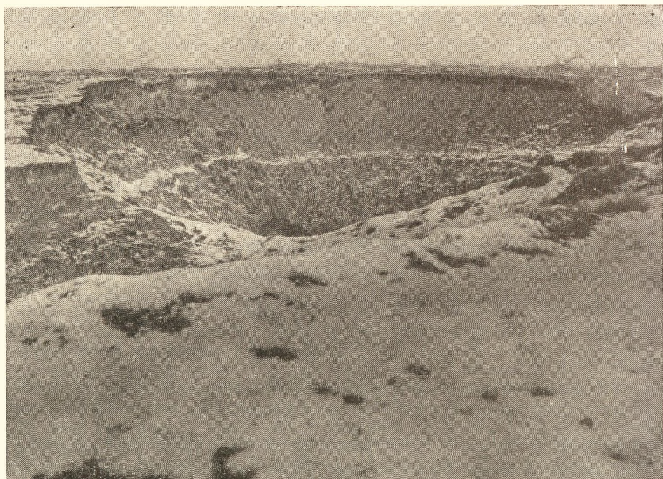
Obr. 1. Lievikovitý prepád v oblasti bane Mier v Novákoch, Vzniká pri dobývaní uhlia metódou komorovania stien na zával.
