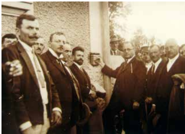
Vloženie schránky s listinou do múru budovy školy v Okúhlom (1925) Zdroj: archív autora
