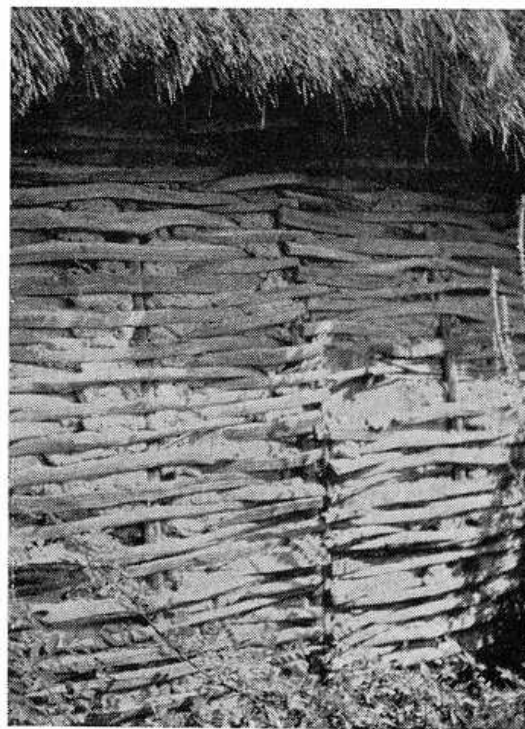
Obr. 7. Ukážka spôsobu vypletania steny. Foto V. U., 1956.
