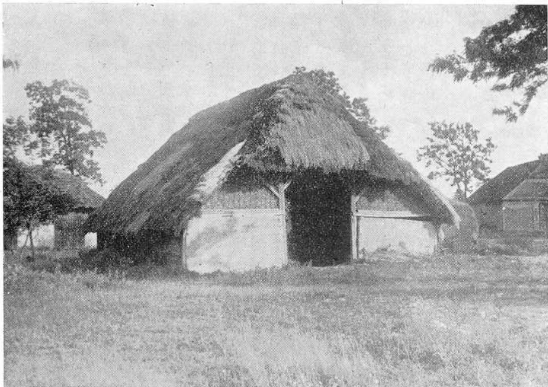
Obr. 8. Murovaná stodola s prútenou časťou stien. Foto V. U., 1956.
