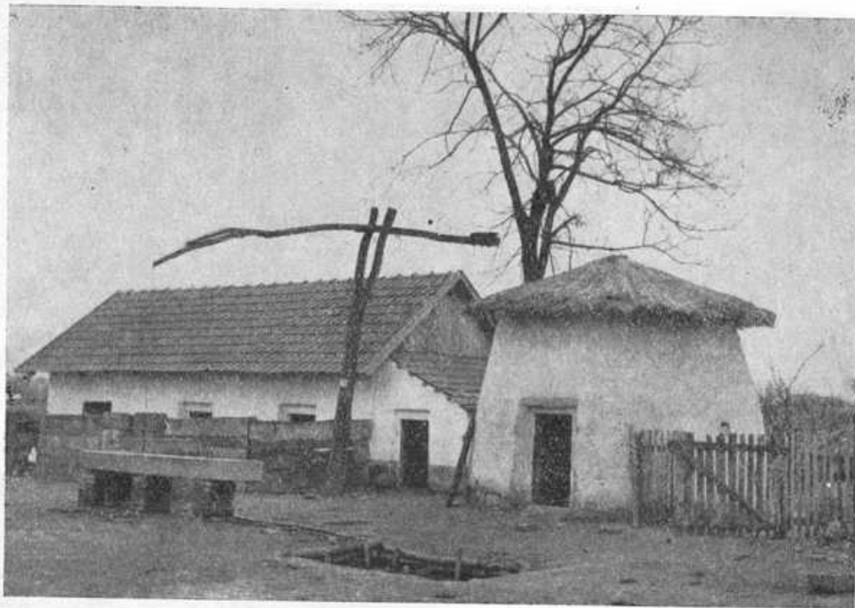
Obr. 8. Gazdovský dvor v Pitvaroši. Foto E. Lazišťan, 1946.
