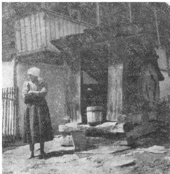
Studňové koleso zbité z dosák. Jasenica, okr. Dolný Kubín. Foto J. Mjartan, 1955.
