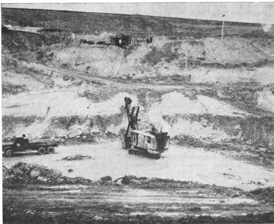
Obr. 3. Pravá strana kanála v mieste vypracovaných sanačných rebier č. 4 a č. 5.
