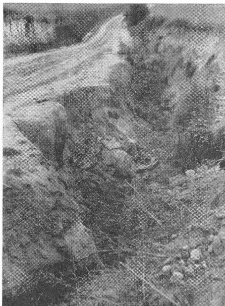
Obr. 5. Detailný záber zachytil rozširovanie eróznej ryhy v auguste 1964. Foto J. Košťálik.
