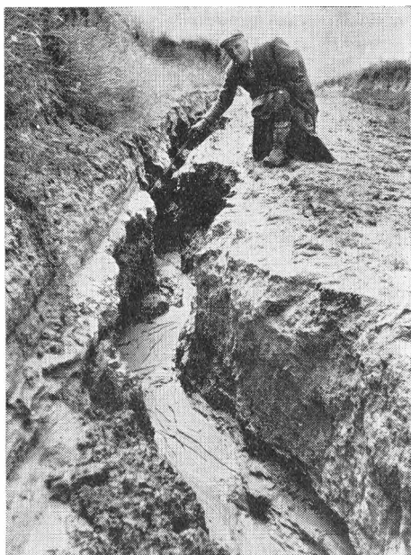
Obr. 4. Búrkový dážď 10. a 11. júla 1959 v záreze cesty západne od Dvorníkov spôsobil 90 cm hlbokú ryhu, ktorá sa ďalej prehľbuje. Foto J. Košťálik.
