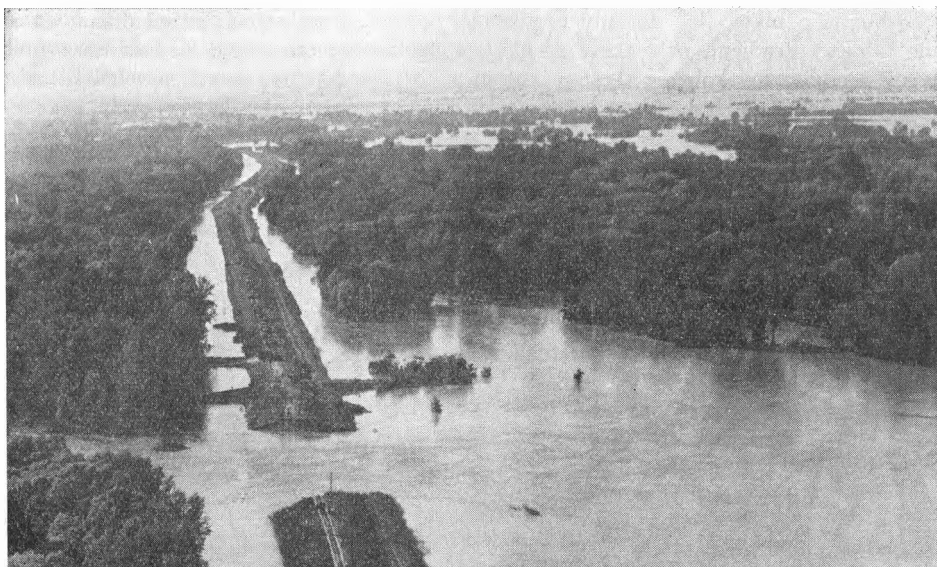
Obr. 9. Prietrž ľavostrannej dunajskej hrádze pri Klúčovci. Foto ČTK.
