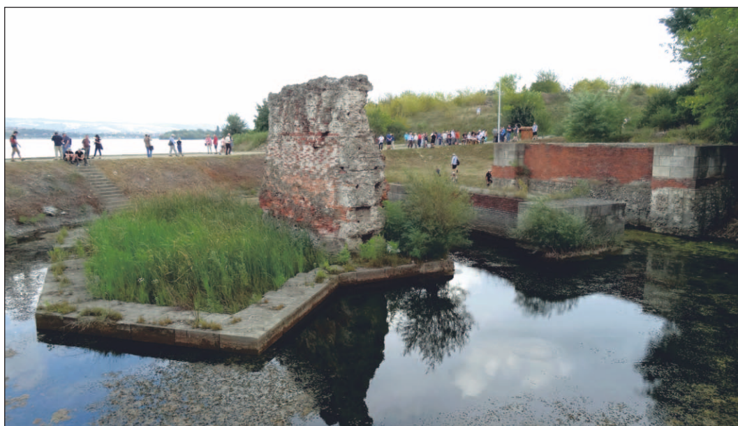
Abb. 9. Reste des südlichen Brückenkopfs bei Kostol (Serbien) von Westen gesehen, Zustand September 2018 (Foto R. Ployer).
