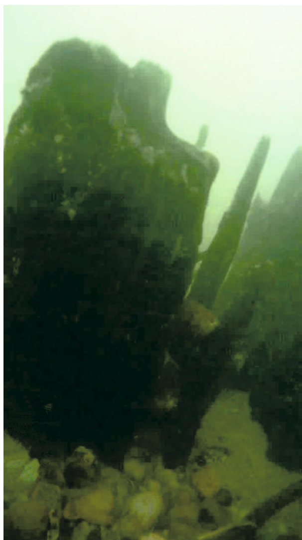
Obr. 9. Iža. Pohľad na jeden z drevených stĺpov z piliera 2. Foto L. Fillo.
