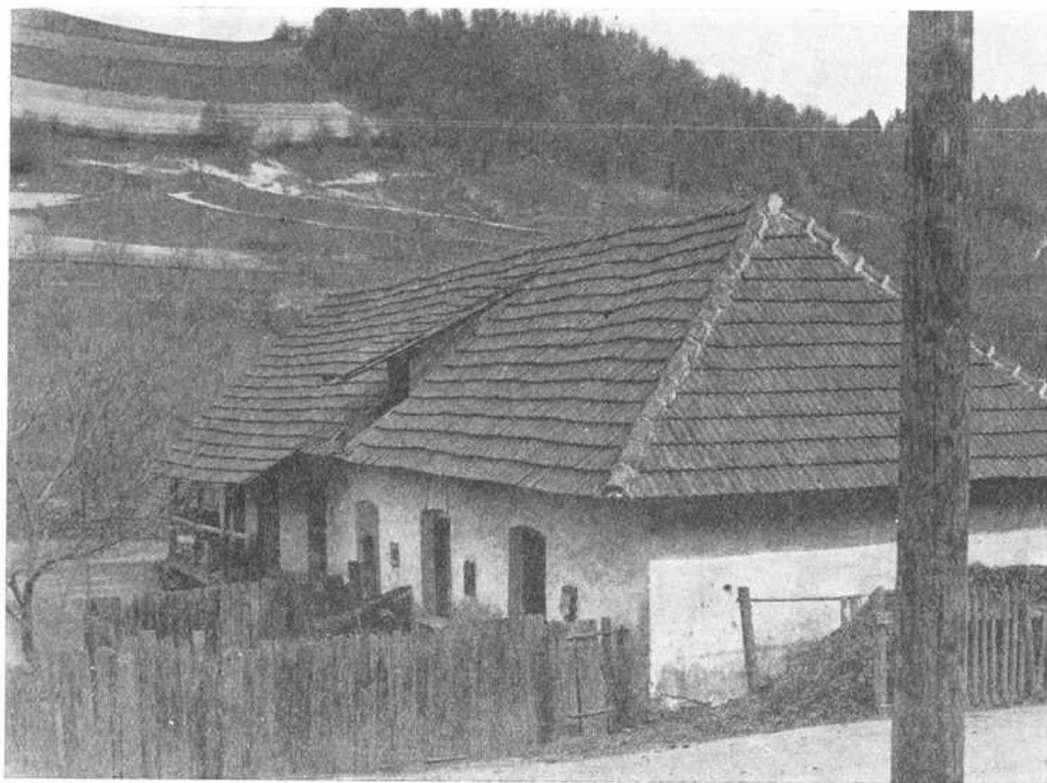
Obr. 5. Spoločné murované maštale a komory troch bratov, postavené r. 1924.
