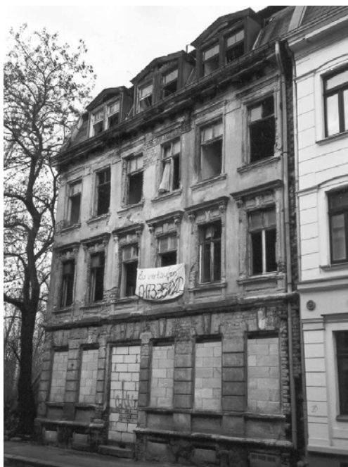
Obr. 1. Chátrající opuštěná budova v CSA Neustadt – Neuschönefeld v Lipsku
